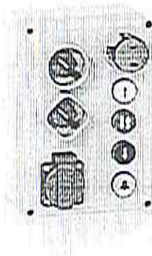
Figura 1: Caja de inspección normalizada, con dispositivos de conmutación, parada de emergencias y toma de corriente.
